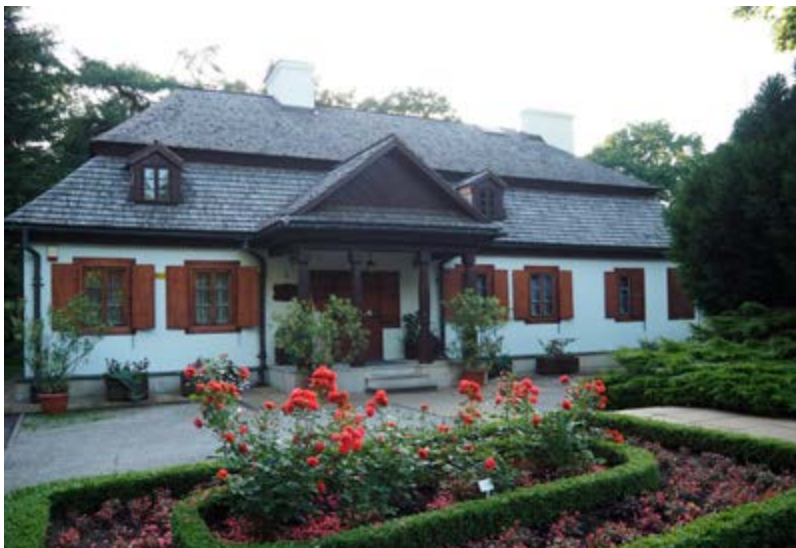
Ryc. 3. Odbudowany dwór, stan 2023 r. Komin górujący nad gankiem to tylko jego niewielka, widoczna z zewnątrz część. Ta zachowana, pochodząca z XVIII w., imponujących rozmiarów kryje się na wysokim strychu. Dodatkowe dwa okna z prawej strony i drugi widoczny komin to część dworu dobudowana przez rodzinę Wagnerów.
