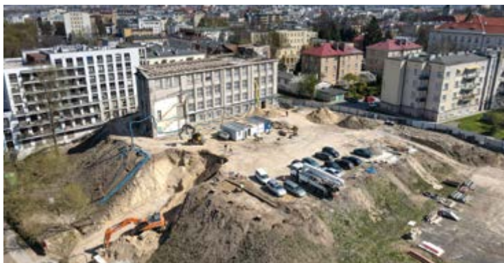
Ryc. 2. Widok ogólny na stanowisko. Stan z kwietnia 2021r. Widok od strony północno-zachodniej.
